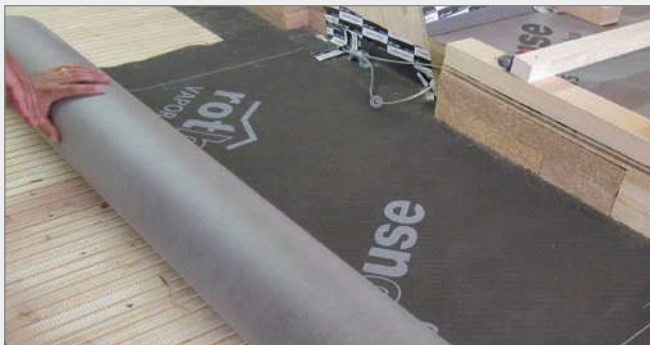
1. Srotolare il telo parallelamente alla gronda.
