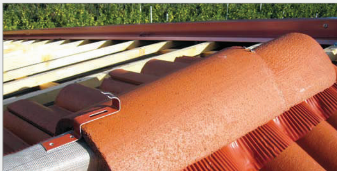
3. avvitando il gancio successivo si fissa automaticamente il coppo
