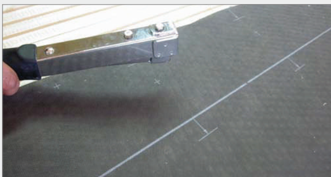
2. Fissare meccanicamente la membrana in vicinanza del bordo superiore.
