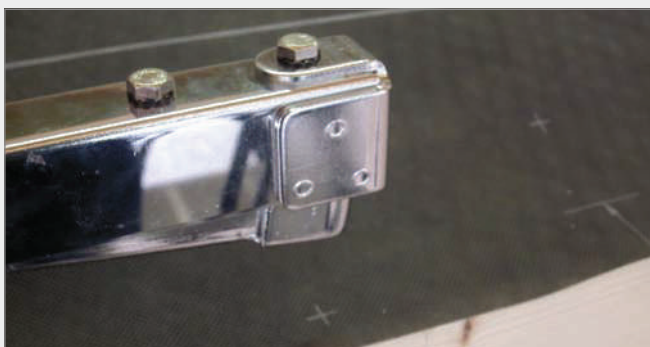
4. Fissare meccanicamente la membrana in vicinanza del bordo inferiore e applicare una graffa ogni 50 cm in corrispondenza della crocetta.
