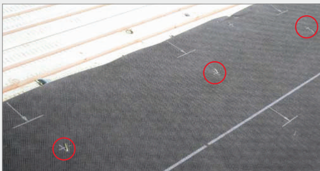
3. Applicare una graffa ogni 25 cm in corrispondenza della crocetta.
