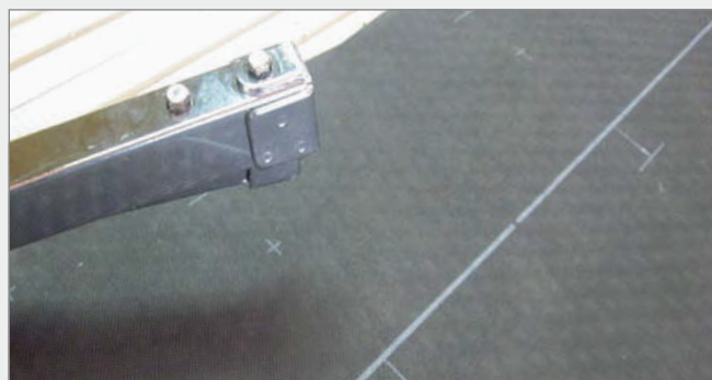
6. Fissare meccanicamente la membrana in vicinanza del bordo superiore.
