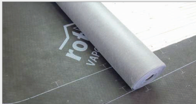
5. Stendere il rotolo successivo parallelamente e sovrapposto al precedente rispettando le linee di sormonto. Si consiglia di sfalsare i riferimenti per la nastratura.
