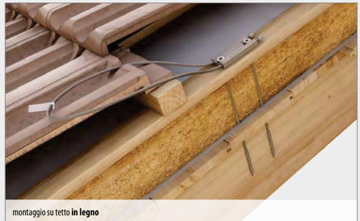
montaggio su tetto in legno
